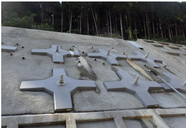
写真-1 赤木地区法面工事現場①
